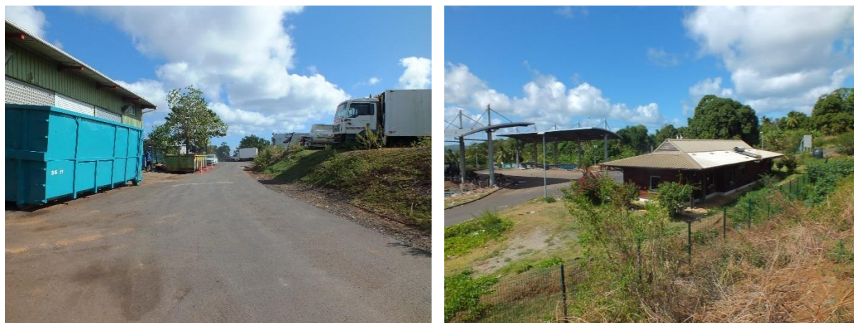
Locaux et parkings de la société STAR (à gauche) et quais de transferts des OM (à droite)
