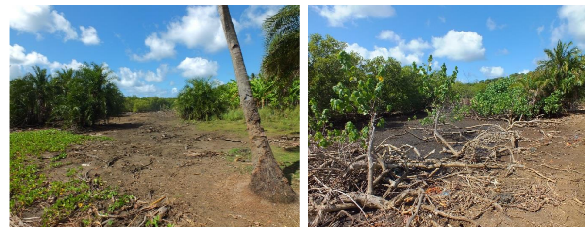
Vues de l'arrière-mangrove dégradée
